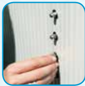
Stålväggen skruvas ihop.
